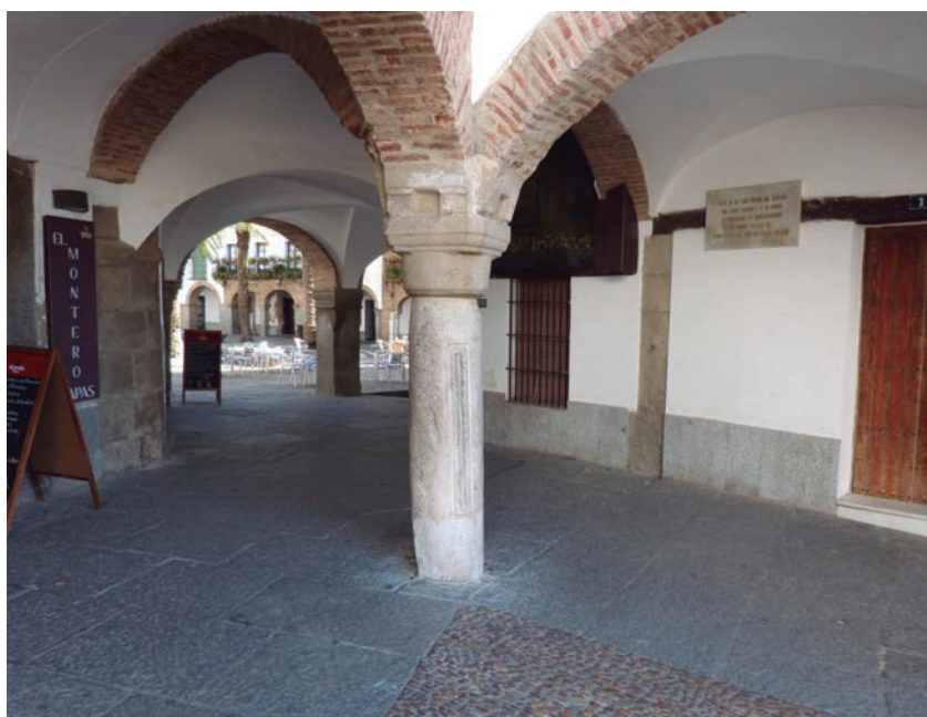
Hendidura para verificación de la longitud de las varas en la Plaza Chica de Zafra
