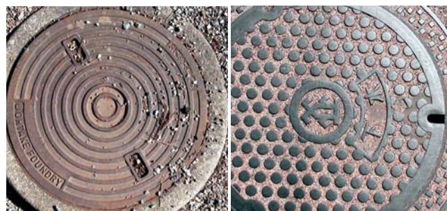
Figuras 5 y 6: Arquetas circulares en suelo nipón (Takayama)
