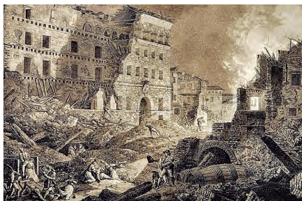
Figura 7. Grabado del edificio del Seminario Viejo después del accidente
